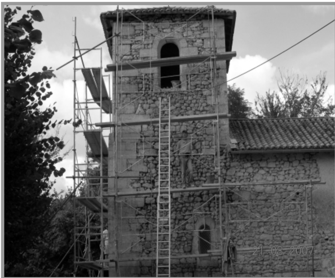
Travaux de restauration de l'église
